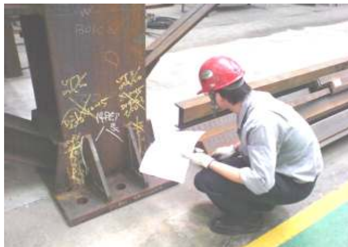
圖一 鋼結構鉚道之目視檢測
