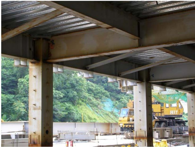
圖十 鋼架安裝完成不久即產生銹蝕
