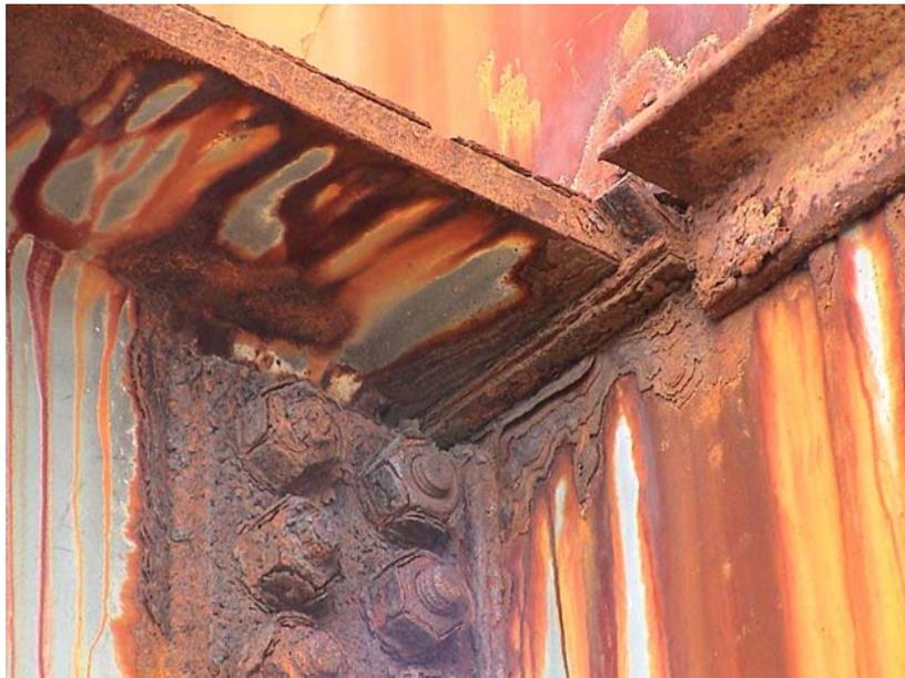
圖四 螺栓與電銲道之D類生銹
